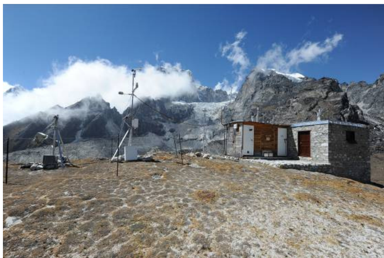
Figura 1. Immagine della Stazione Globale GAW NCO-P dopo i lavori di ampliamento.
