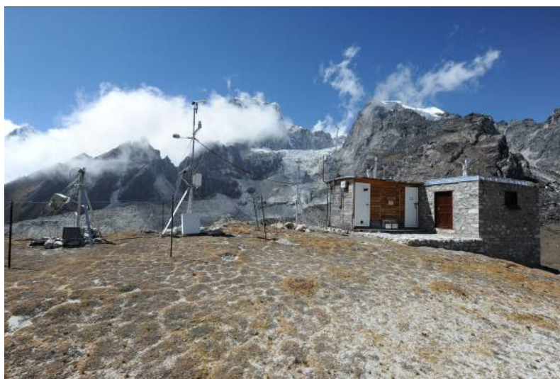
Figure 1. Immagine della Stazione Globale GAW NCO-P dopo i lavori di ampliamento.
